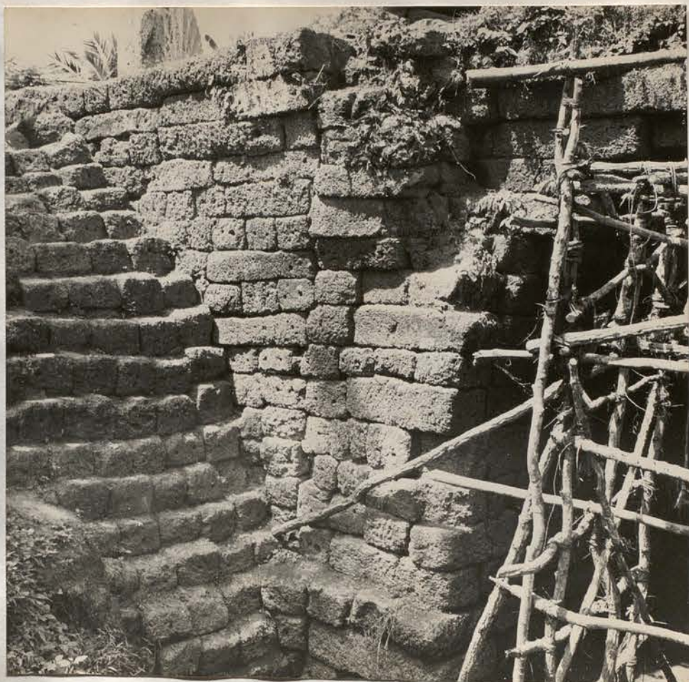
A- Spean Praptos. Culée amont Est, angle Sud-Est, état avant dépose. 28 Juin 1965 (Ph. 6 x 6 n° 1.111)
