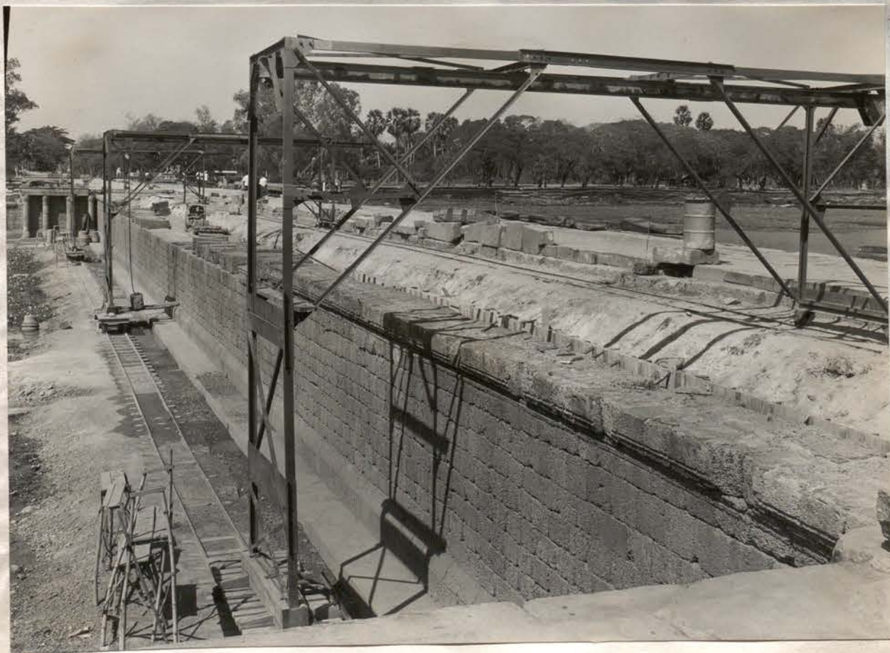
B- Angkor Vat. Chaussée Ouest. Section Est. Moitié Sud. Vue vers Ouest. Remontage du mur avec ponts roulants. 26 janvier 1966 (Ph. 13x18 n°10.211)
