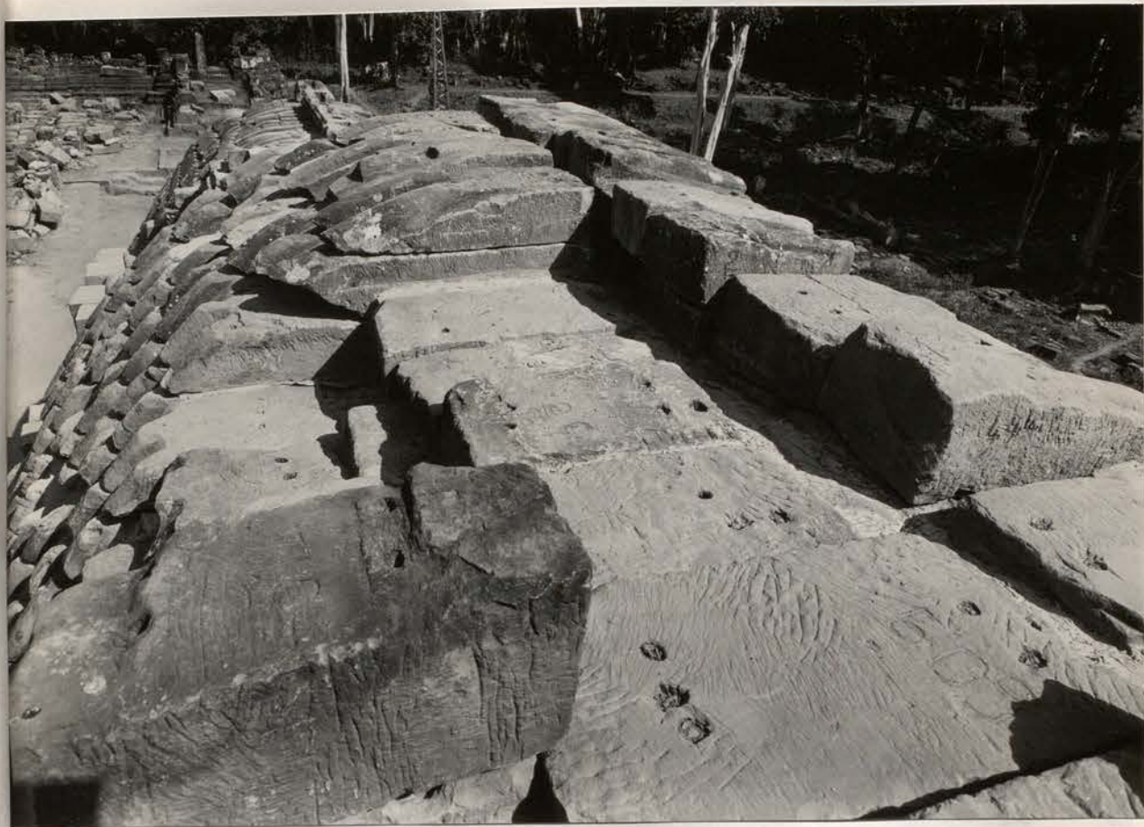
A - Baphuon. Premier Etage. Pavillon axial Est. Ailes Nord. Vue vers Nord. Pose des assises terminales sur la faitière de contre-voûte. - 20 janvier 1966 (Ph. 13 x 18 n° 10.204)
