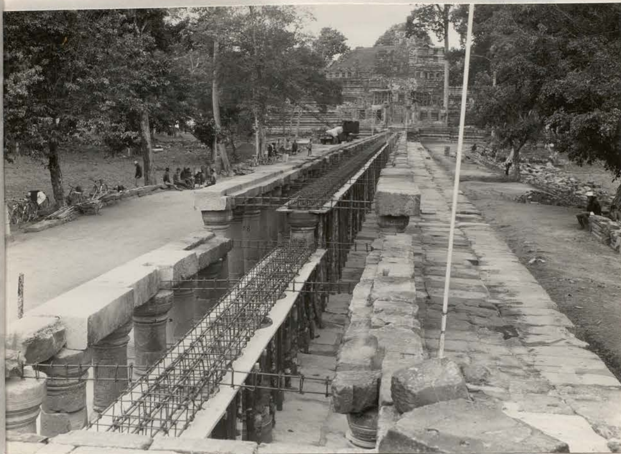
A - Baphuon. Chaussée Est. Section Est. Vue vers l'Ouest. Ferrailage de l'architrave axiale. 10 Avril 1965 (Ph. 13x18 n°10.123)
