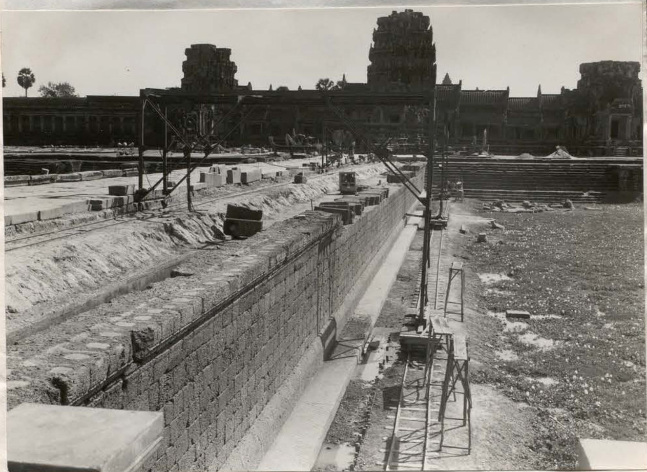
A- Angkor Vat. Chaussée Ouest. Section Est. Moitié Sud. Vue vers Est. Remontage du mur de soutènement. 26 janvier 1966 (Ph. 13 x 18 n° 10.210)
