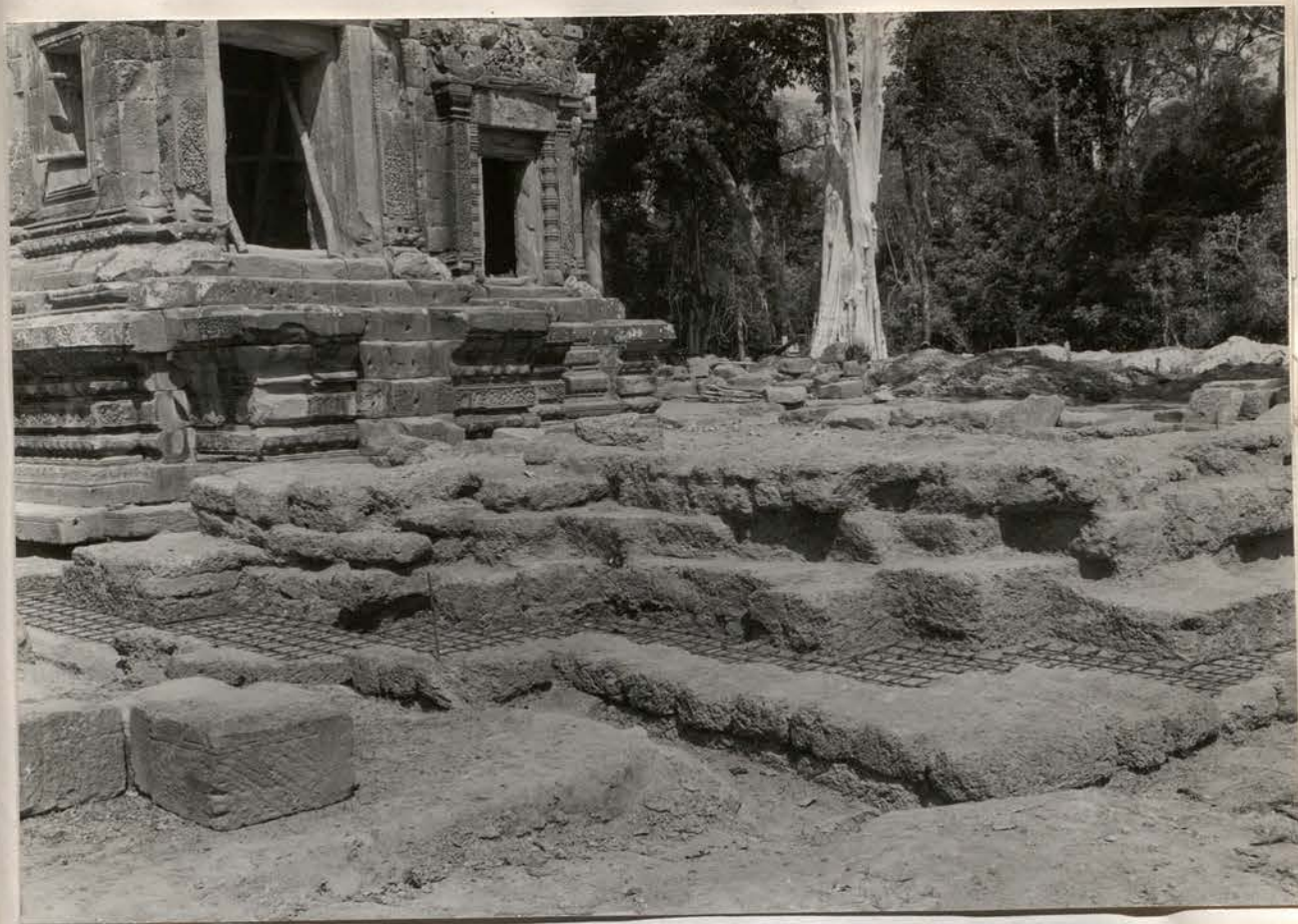
A- Thommanon. Terrasse Est vue vers Nord-Ouest. Ferrailage de la dalle de fondation encastree dans la laterite. 10 Mars 1965 ( Ph. 13 x 18 n° 10.119 )
