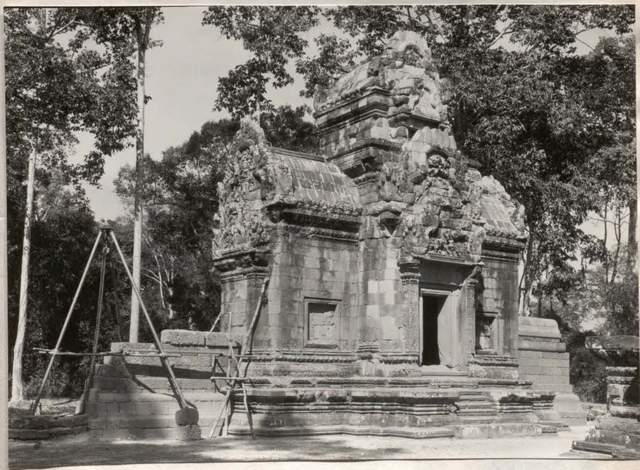
B- Thommanon. Pavillon d'entrée Ouest, face Est. Restitution des départs du mur d'enceinte. 26/1/66 (Ph.13x18 n° 10.214)
