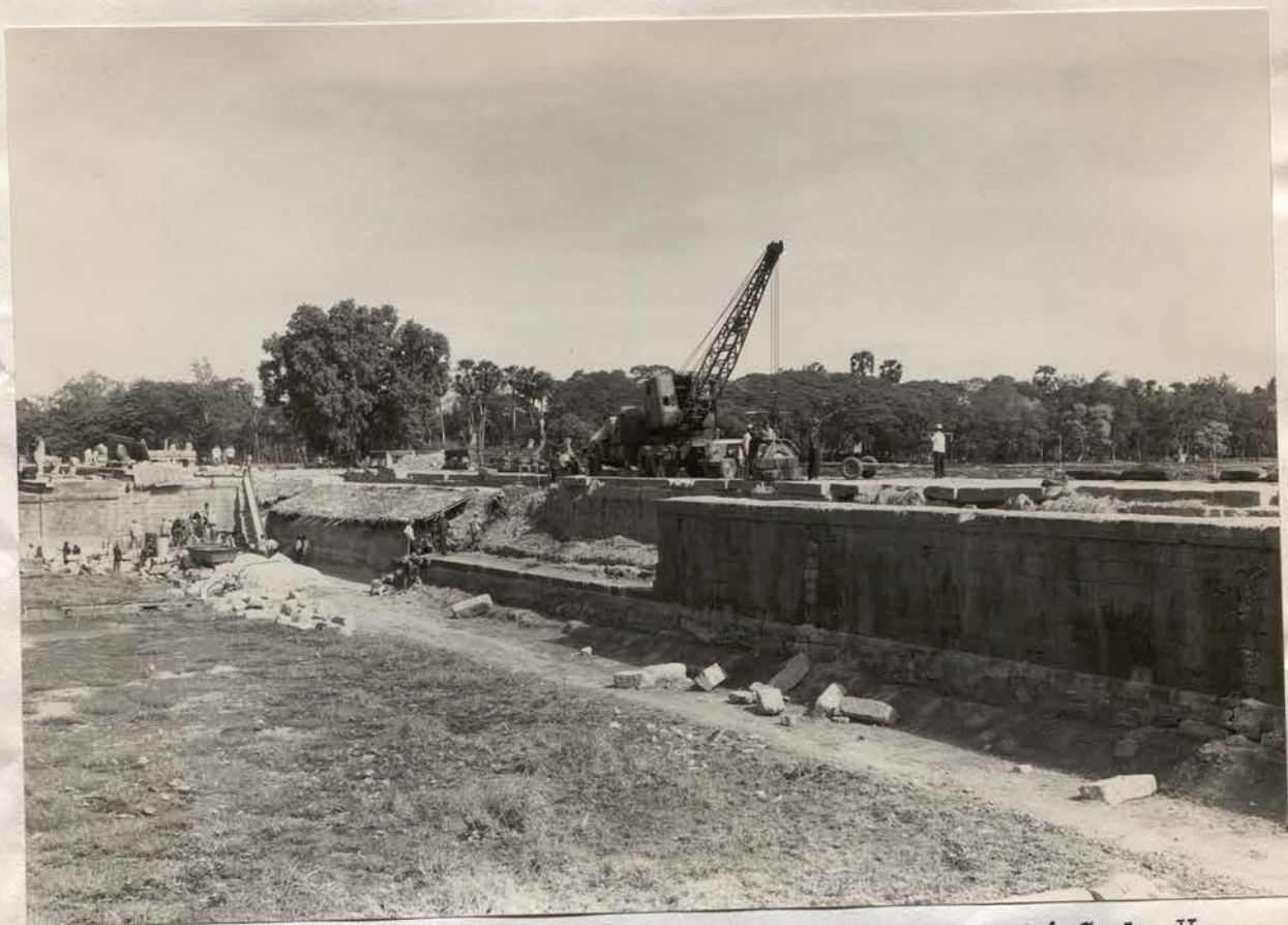
A- Angkor Vat. Chaussée Ouest. Section Est. Moitié Sud. Vue vers Nord-Ouest. dépose. batardeau et toiture de protection. 8 juin 1965 (Ph. 13x18 n°10.154)
