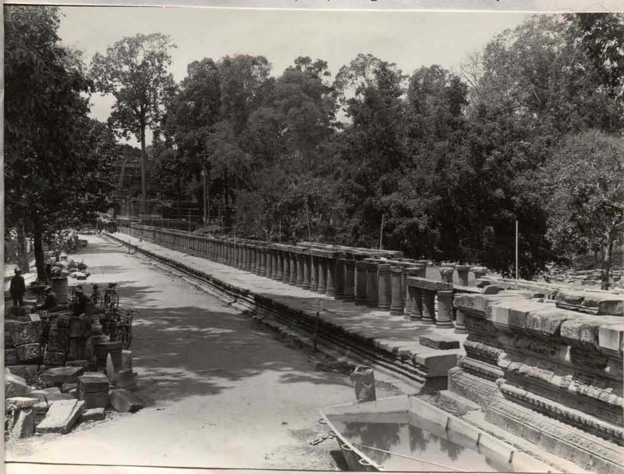
B - Baphuon. Chaussée Est. Section Est. Côté Sud. Vue vers Nord-Ouest. Colonnes reposées. 12 Mars 1965 (Ph. 13x18 n°10.121)
