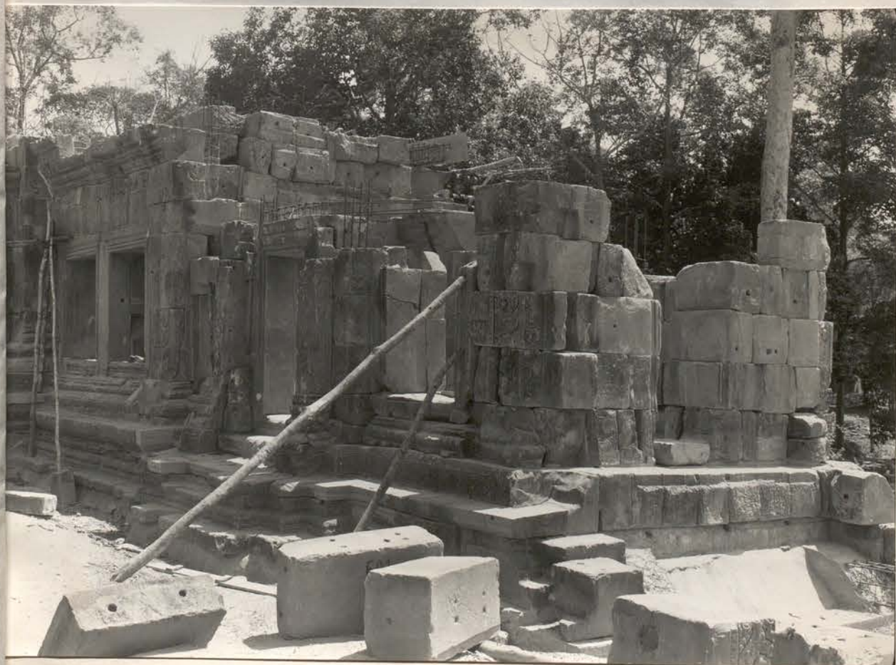
B - Baphuon. Premier Etage. Pavillon axial Est. Aile Sud. Angle Sud-Ouest. Vue vers Nord-Est. Dispositifs internes de confortation - 29 Avril 1965 (Ph. 13 x 18 n°10.127)
