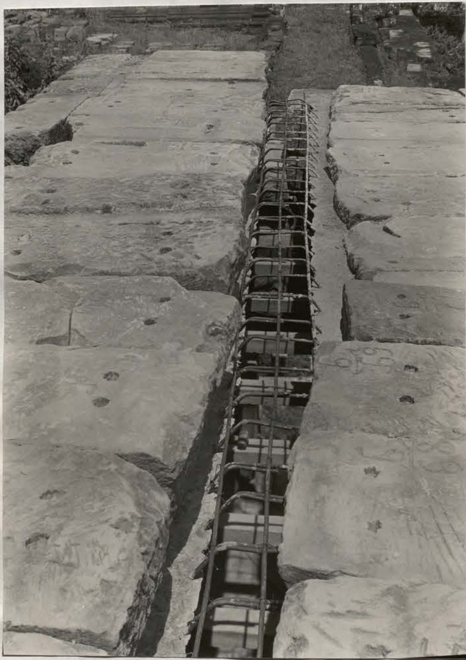
Baphuon - Premier Etage. Pavillon axial Est. Aile basse Nord. Vue vers Nord. Ferrailage de la faîtière de la contre-voute.- 13 Octobre 1965 (Ph.13x18 n°10.194).
