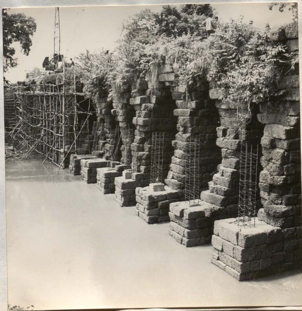
B- Spean Praptos, front amont, vu vers Est. Principe de remontage de piles autour d'un axe en B.A. 28 Juin 1965 (Ph.6x6 n°1.104)
