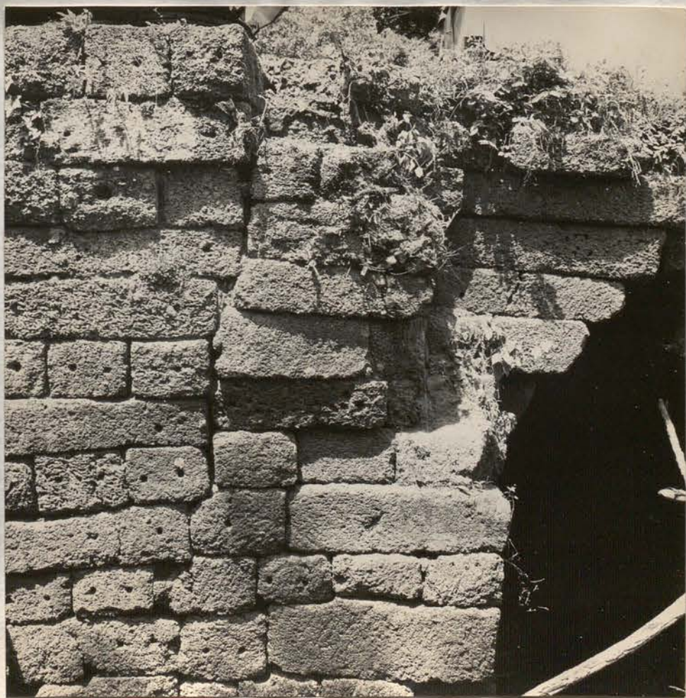
B- Spean Praptos. Culée amont Est, premier encorbellement état avant dépose. 28 juin 1965 (Ph.6 x 6 n° 1.109)
