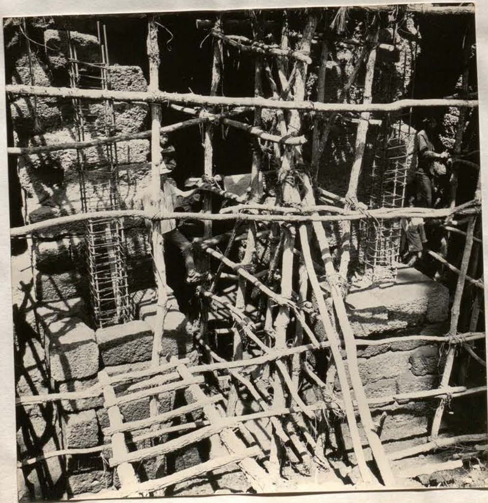
B- Spean Praptos, front amont, 4 e pile Est. Détail du remontage. 28 juin 1965 (Ph. 6 x 6 n° 1.113)
