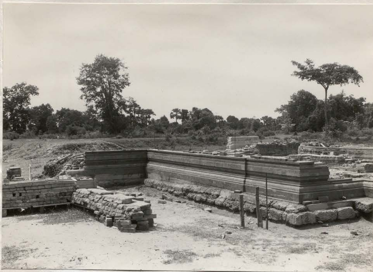
A- Kravan. Pavillon d'entrée oriental. Angle Nord-Ouest vu vers Sud-Est. Remontage. 16 Juillet 1965 (Ph.13x18 n°10.174)
