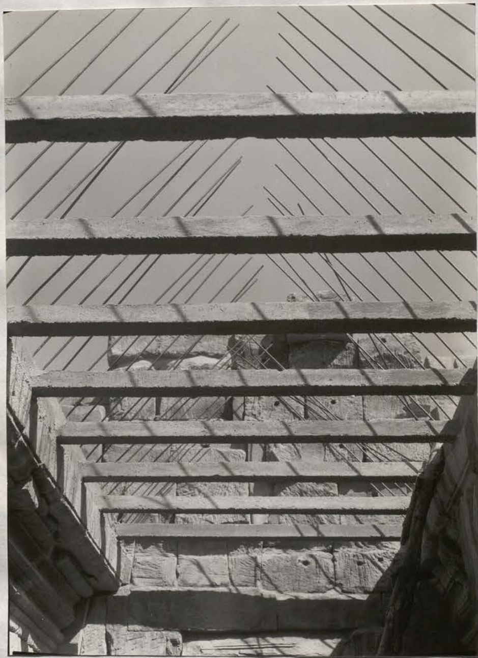
Baphuon - Premier Etage. Pavillon axial Est. Aile Sud. Vue vers Nord. Solives du plafond coullées 20 janvier 1966 (Ph.13x18 n°10.209)
