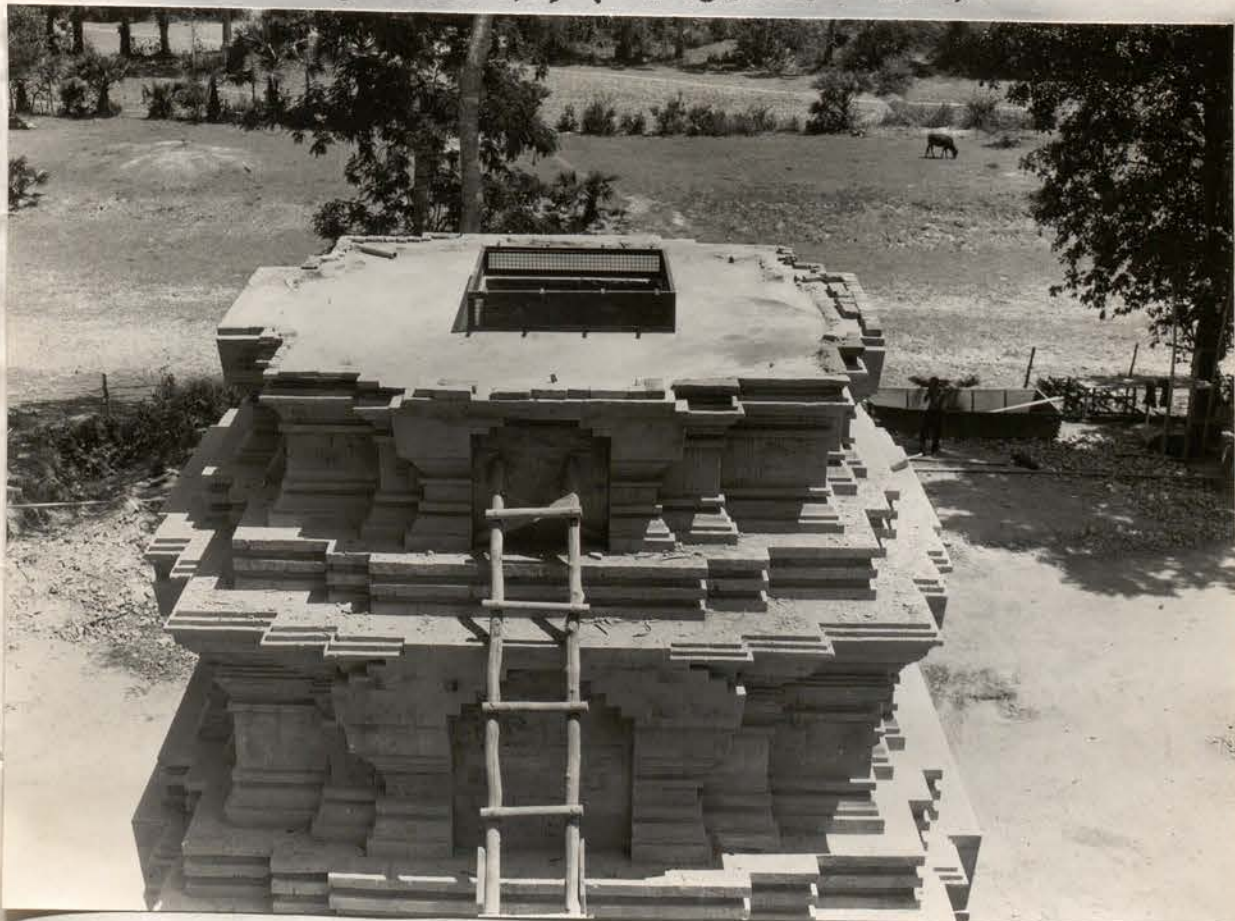
B- Kravan. Tour extrême Sud. 2 e faux étage, face Nord vue vers Sud. Reconstruction terminée, montage du lanterneau et aménagement des chapes d'étanchéité. 23 Avril 1965 ( Ph.13x18 n°10.126)
