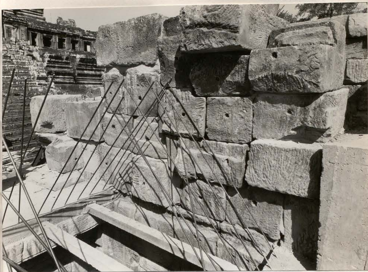
A- Baphuon - Premier Etage. Pavillon axial Est. Aile Sud. Raccord avec le pavillon central. Dispositif pour le faux-plafond et la contre-voûte. 20/1/66 (Ph. 13x18 n°10.206)
