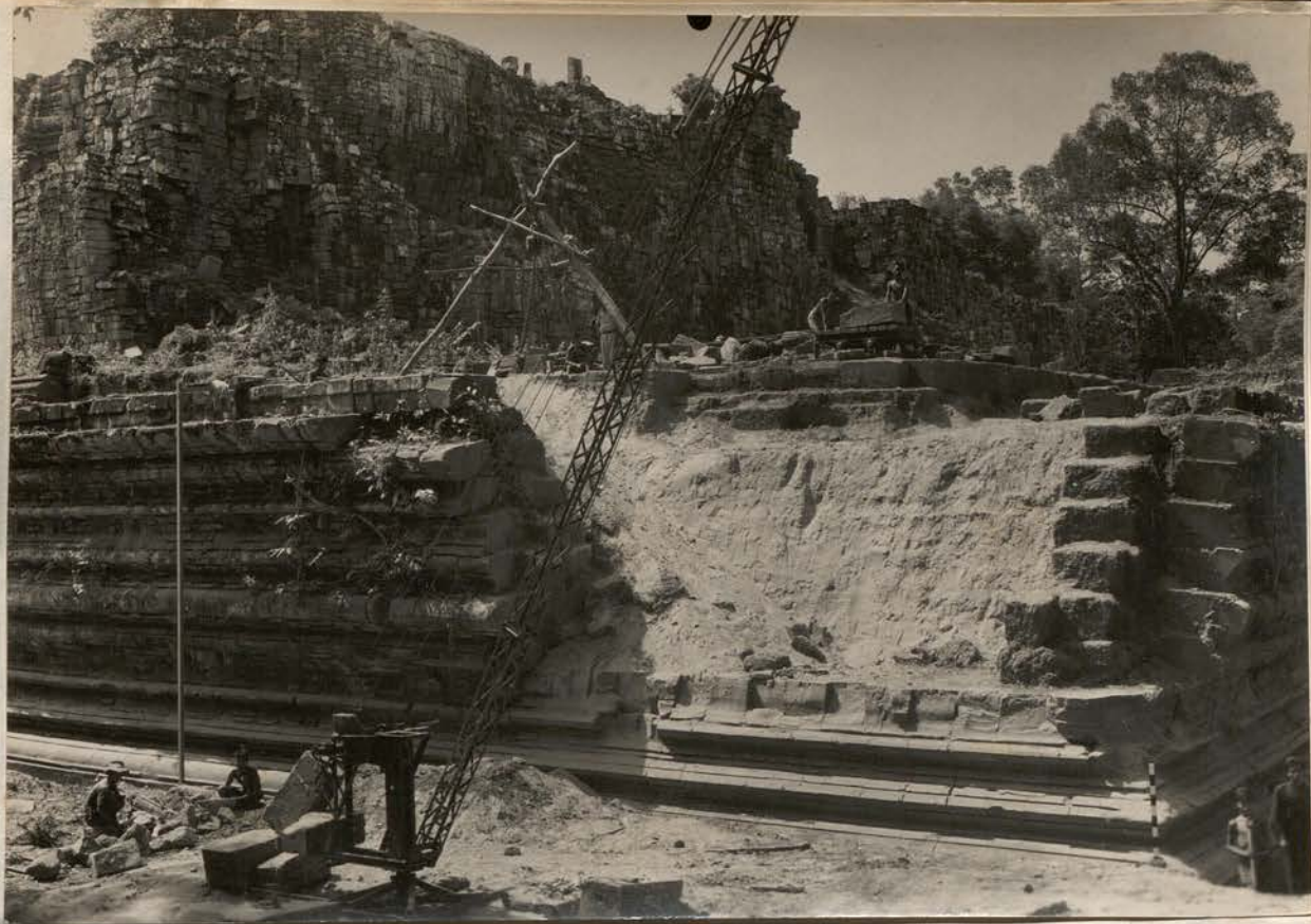
8420 - Baphuon - 1 er étage - Angle N.W. Vue d'ensemble
