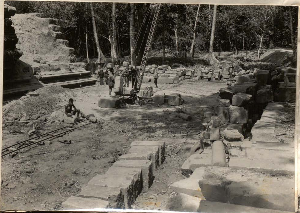
8419. Id. Angle N.W. - dégagement des éboulis -
