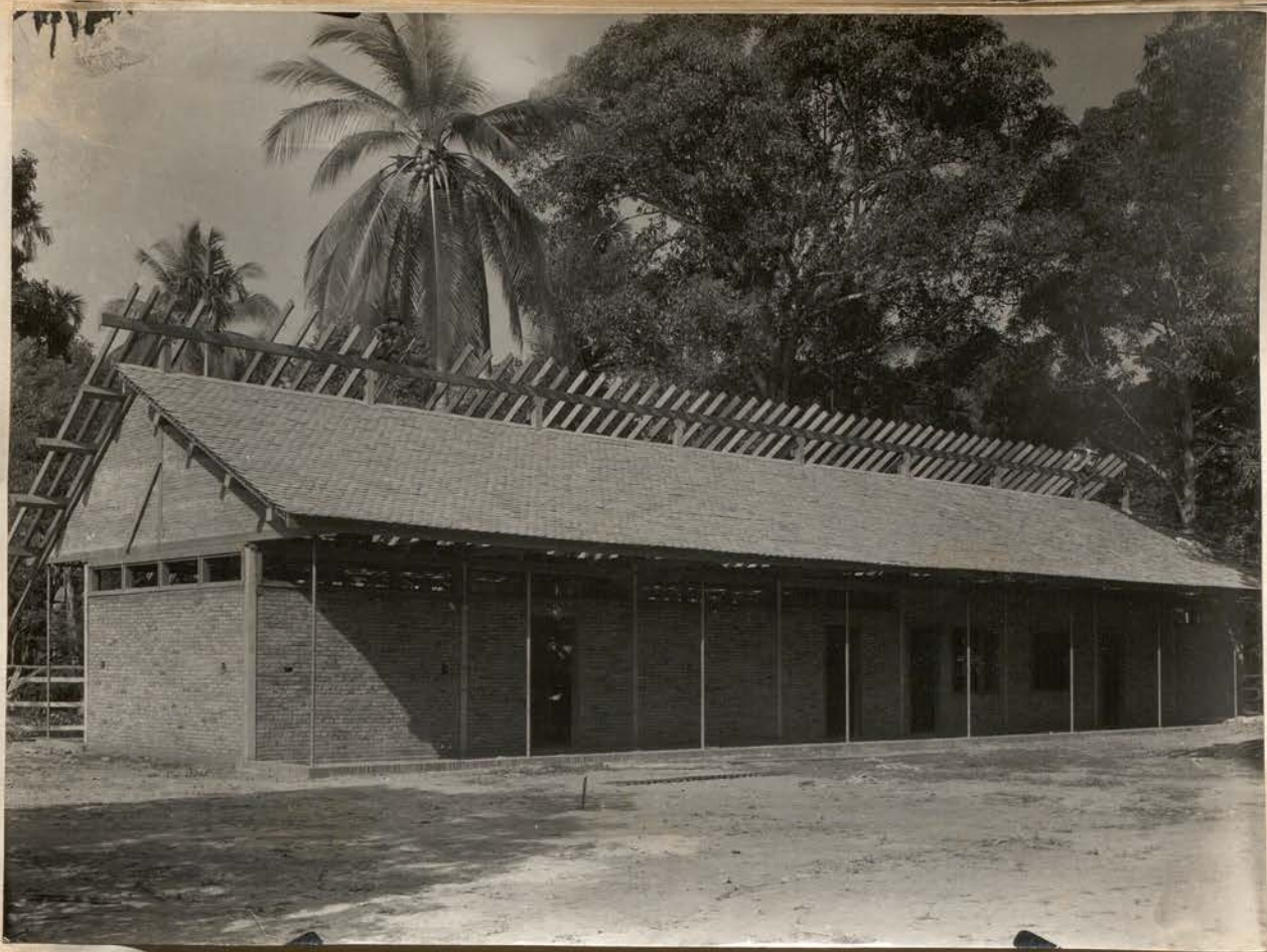
8422. Août 59. EFEO. Bâtiment des Services - Face Nord
