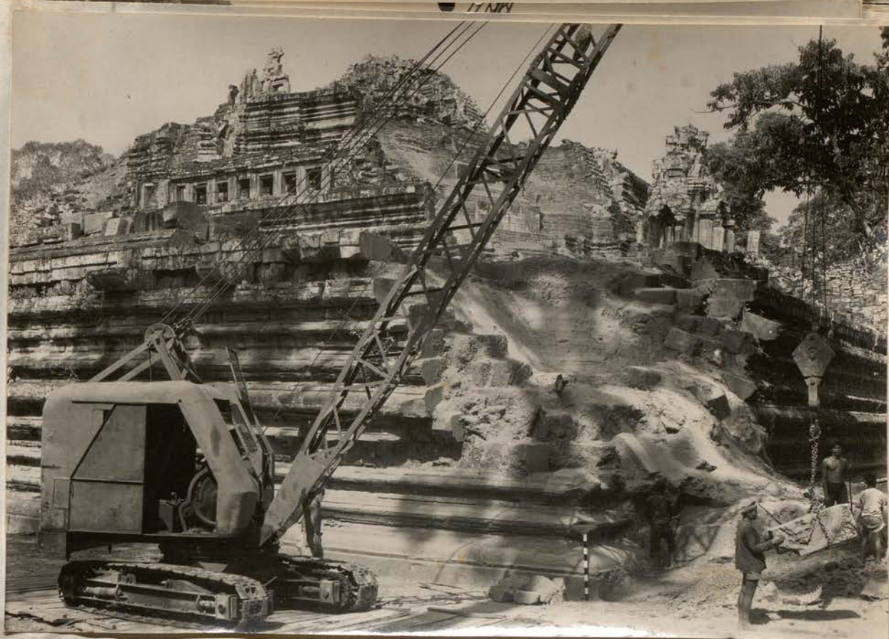
8418. Barbuon - 1 er étage - angle NE - dégagement des éboulis
